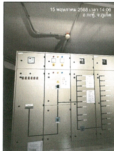
รูปภาพที่ 2.45 Capacitor Bank
