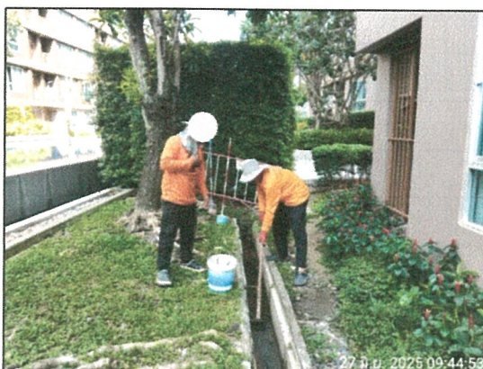
รูปภาพที่ 2.46 การขุดลอกตะกอนรางระบายน้ำ
