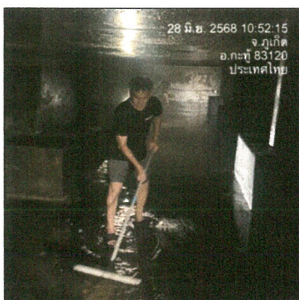
รูปภาพที่ 2.33 ถังเก็บน้ำสำรองและการล้างถัง
